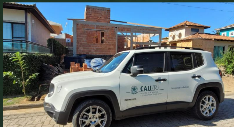
Fiscalização de obra na cidade de Búzios
